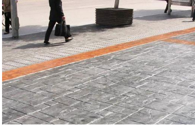
现浇（压膜）混凝土
