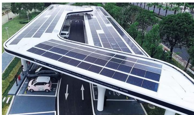
光储充一体式充电站
